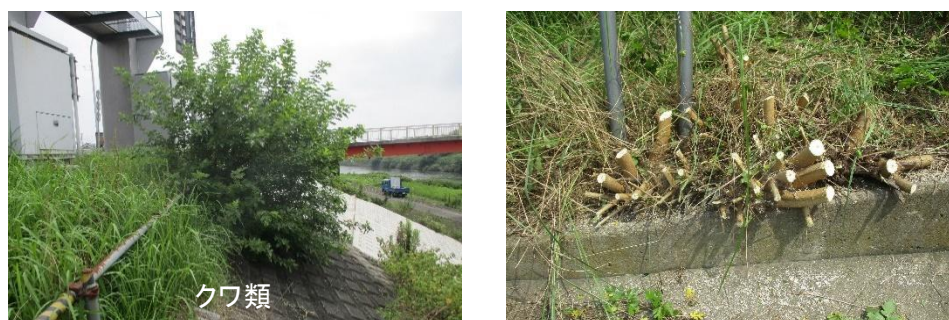
図 2.2-6 クワ類の護岸への侵入
