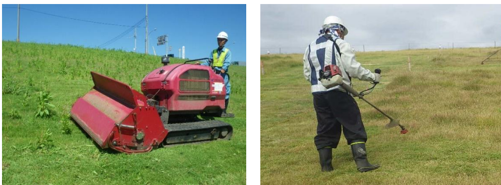
図 1.1-2 除草工（左：ハンドガイドによる機械除草、右：肩掛けによる人力除草）
