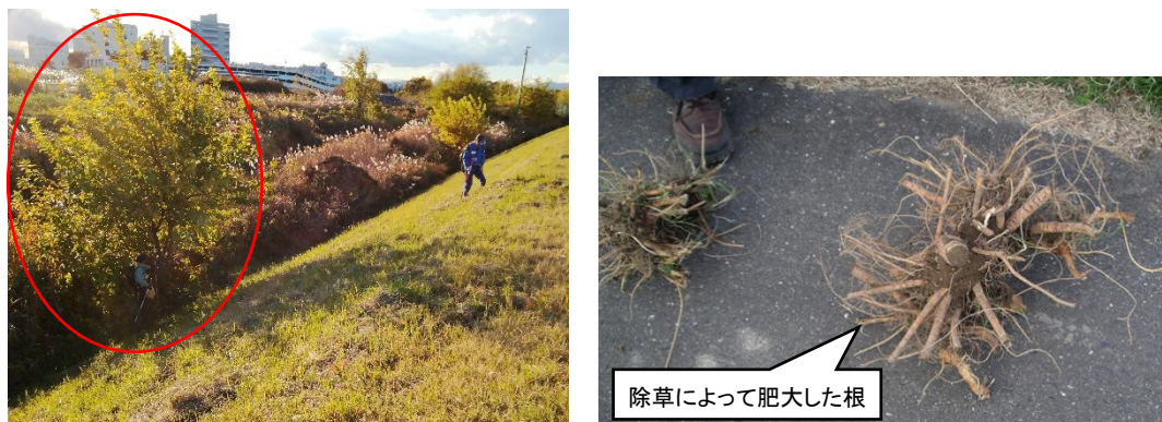
図 2.2-2 左：堤防に侵入したクワ（樹高 5m 程度）（多摩川）、 右：除草によって肥大化したクワの根（烏・神流川）
