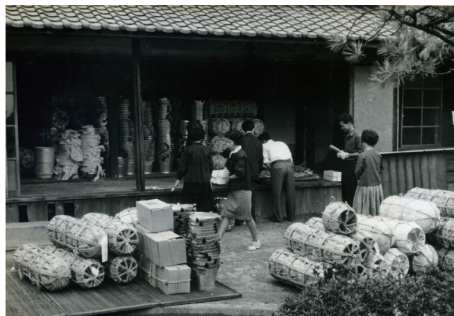
決壊堤防の仮締切工事に携わった市民による作業の様子(高浜市提供)
