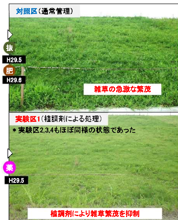
図-7 植調剤の有無による養生初期の雑草繁茂量の違い (H29.7管理実施前の状態)
