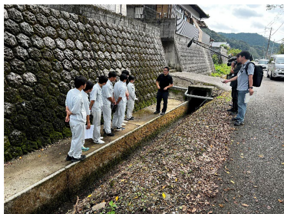
図5-4 嵩上げ家屋の下で、元の家屋の高さと現状について説明 撮影：本田
