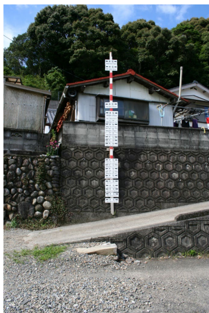
図 3-10 激特事業改修前の水位標
