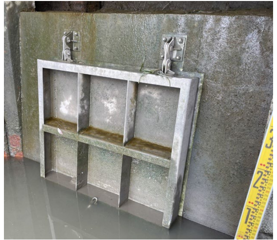
図2-4 二丁井樋の沖端川出口とフラップゲート
