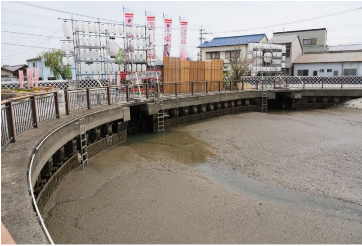
図2-4 二丁井樋の沖端川出口とフラップゲート
