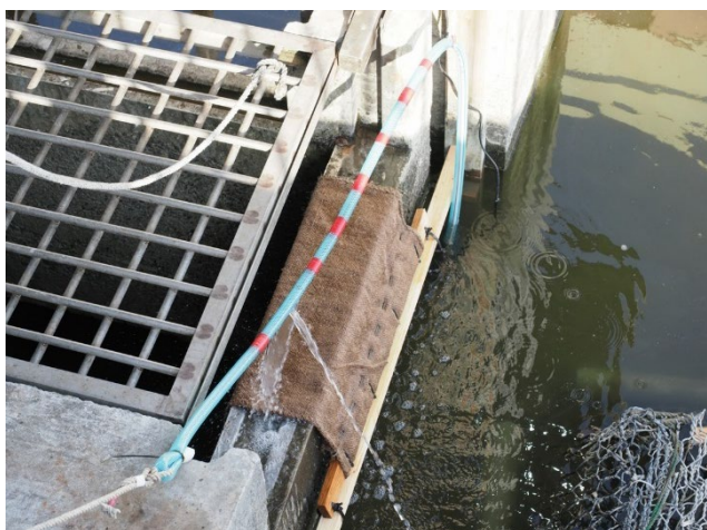
図2-7 シラスウナギ遡上促進システムの麻布と呼び水ポンプ
