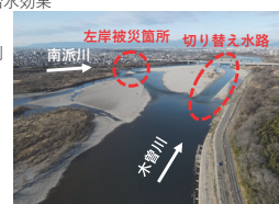
図0.1 木曽川南派川合流点付近左岸護岸被災箇所復旧に向け 右岸砂州に掘削した水路 (2024(R6)年2月撮影写真に加筆) 2
