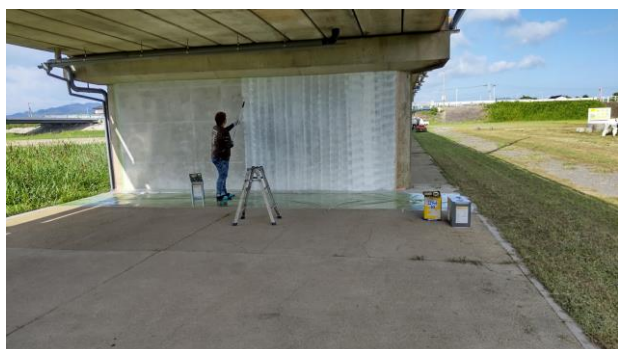
写真 2.5-5 エマルジョン処理(下塗り)
