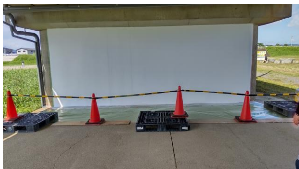
写真 2.5-6 エマルジョン処理(完成)
