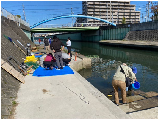
写真 2.39 松ノ鼻橋付近での組立作業
