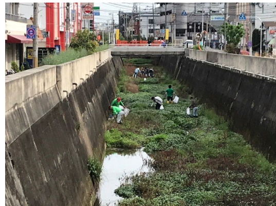
写真 2.18 谷田川河川清掃の様子
