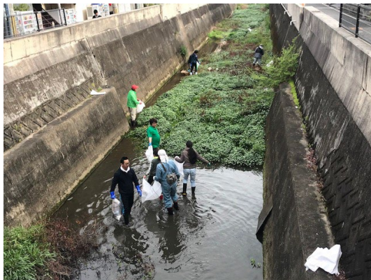
写真 2.17 谷田川河川清掃の様子
