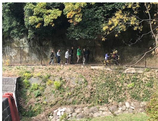
写真 2. 34 野崎中川導流堤
