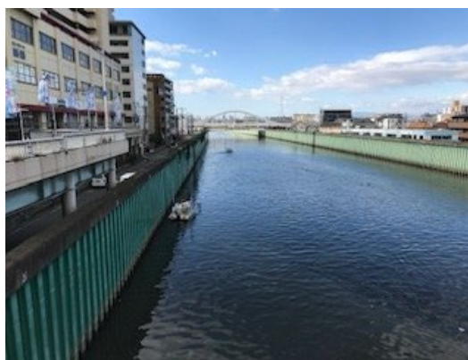
写真 2.6 恩智川・寝屋川での河川清掃
