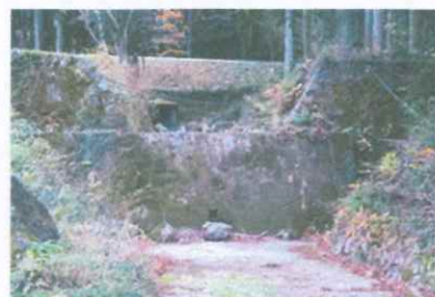
図4-12 上遠野川砂防堰堤
