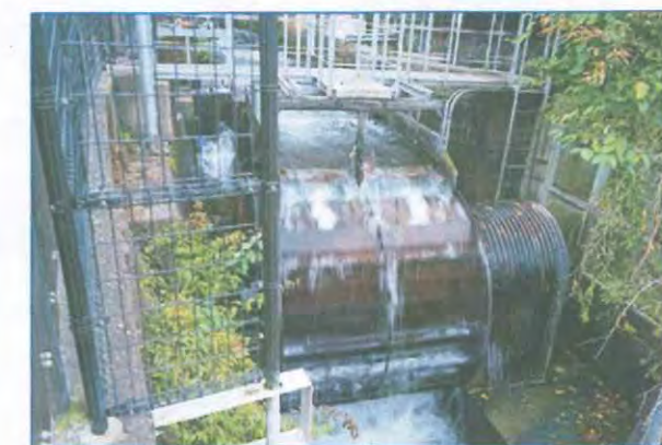
図4-10 都留市家中川小水力市民発電所
