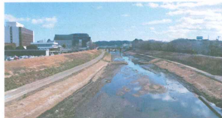
図5-2(1) 夏井川水系新川下流堤防(土堤防)
