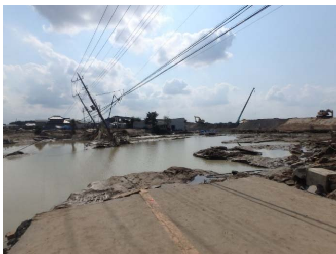
写真 1.2 破堤点（三坂町） 1)
