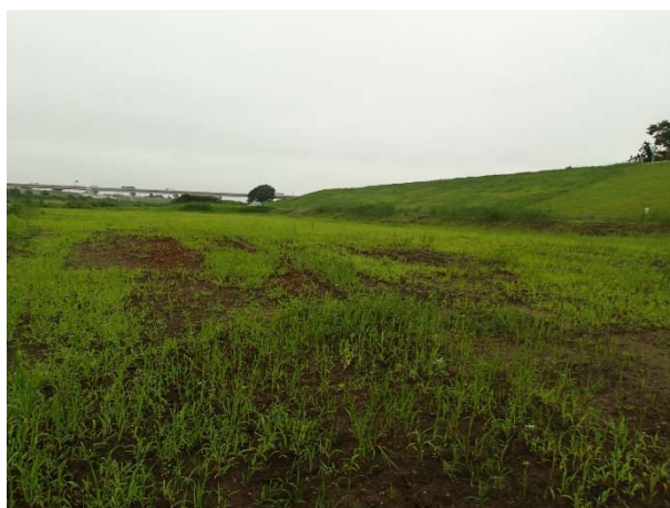
写真 1.4 高水敷掘削の直後の様子
