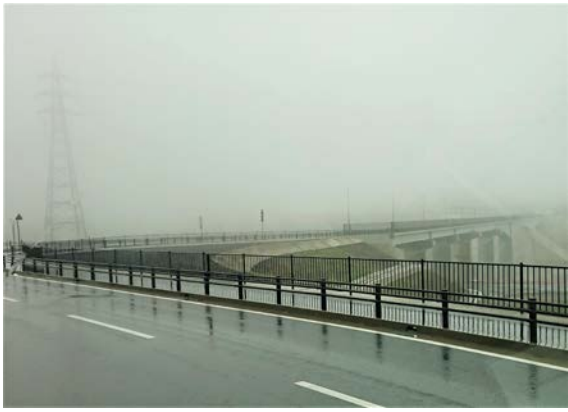
写真 2. 10-10 開通直後の南阿蘇大橋
