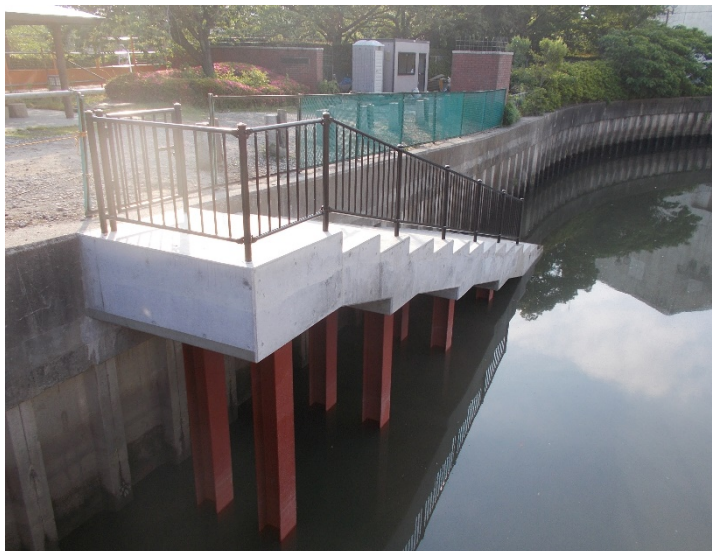
写真22 令和2年7月31日待望の船着場が完成
