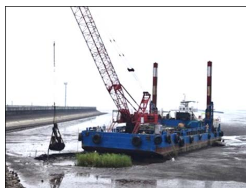
図 4．カットバージ浚渫船によるヒガタアシ除去（白川，2015 年）
