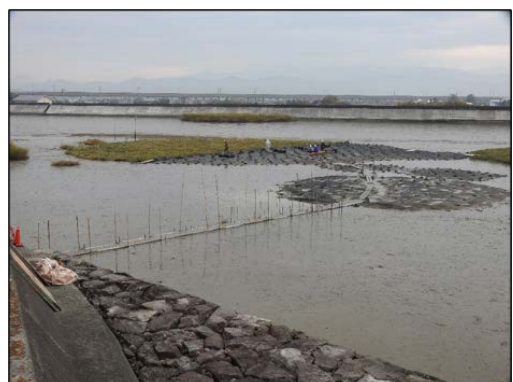
図 5．防草シートの設置作業風景
