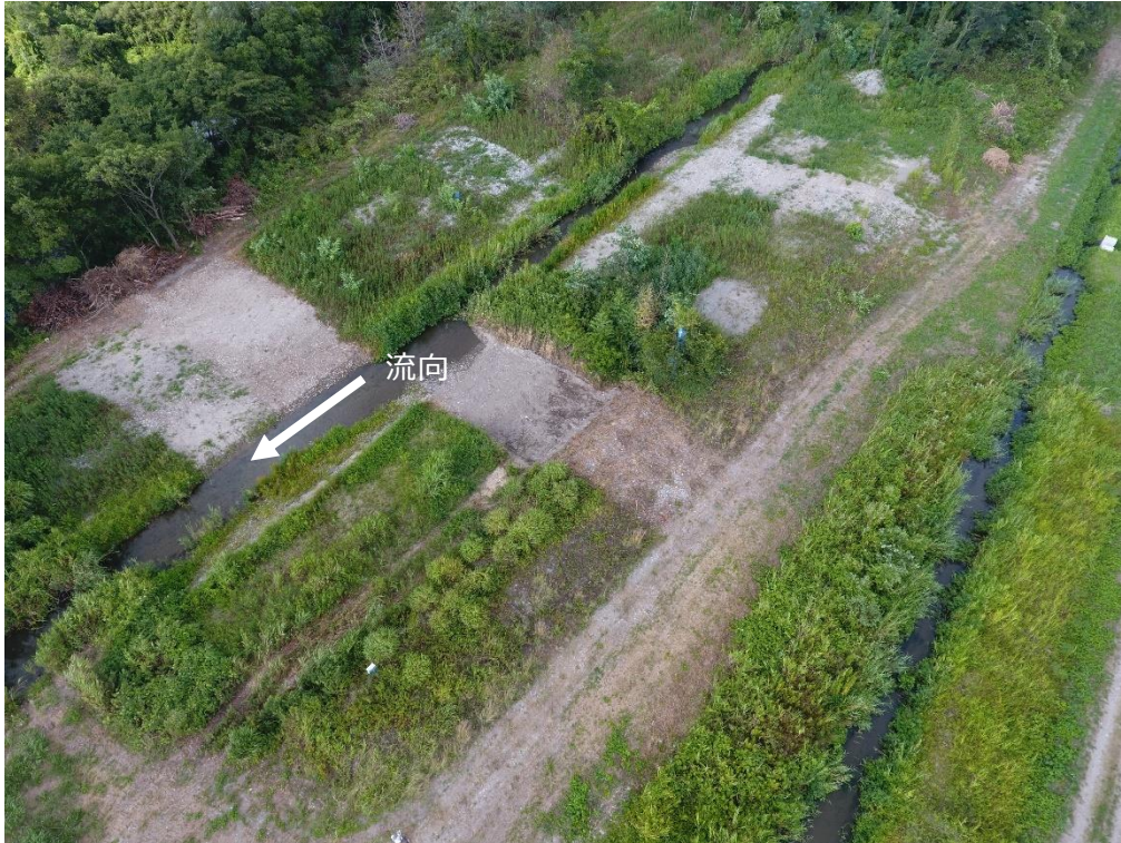
写真 4.1 各月に行われた樹木抜開と掘削の状況（斜め写真）
