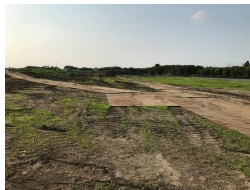
写真 1.4 河道掘削の一例
