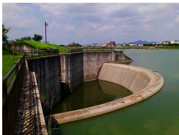
図 3.3.9 狭山池ダムの調査
