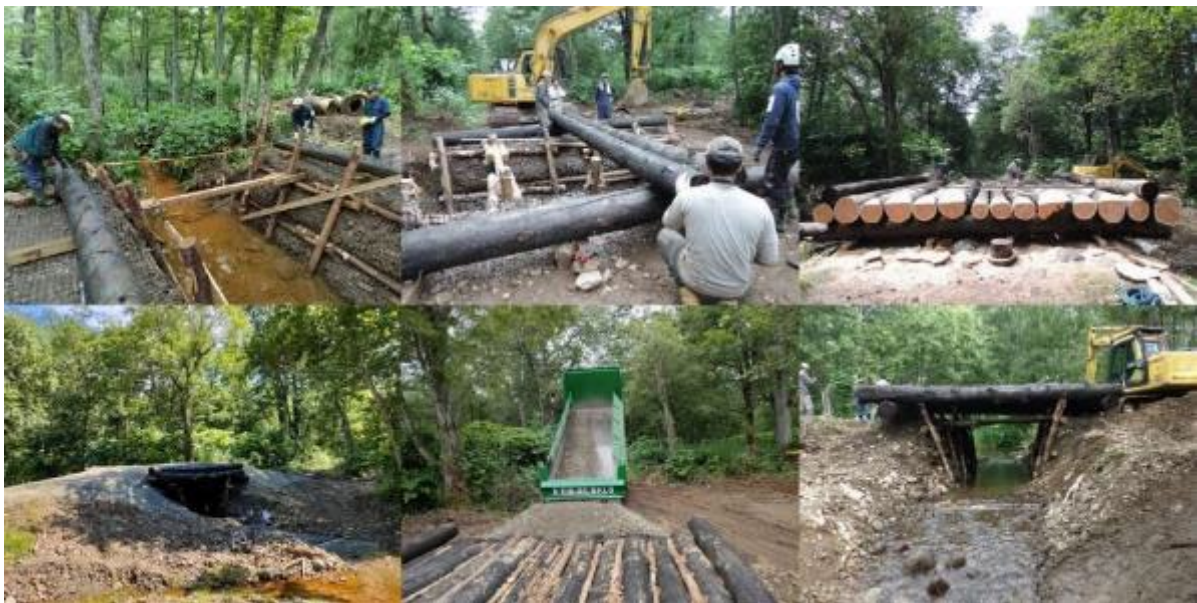
写真7 橋梁の作成風景 左上から時計回りに、（上段）護岸・台座の施工、橋桁の設置、橋桁の加工、（下段）作成された河道、砂利敷設、完成写真。
