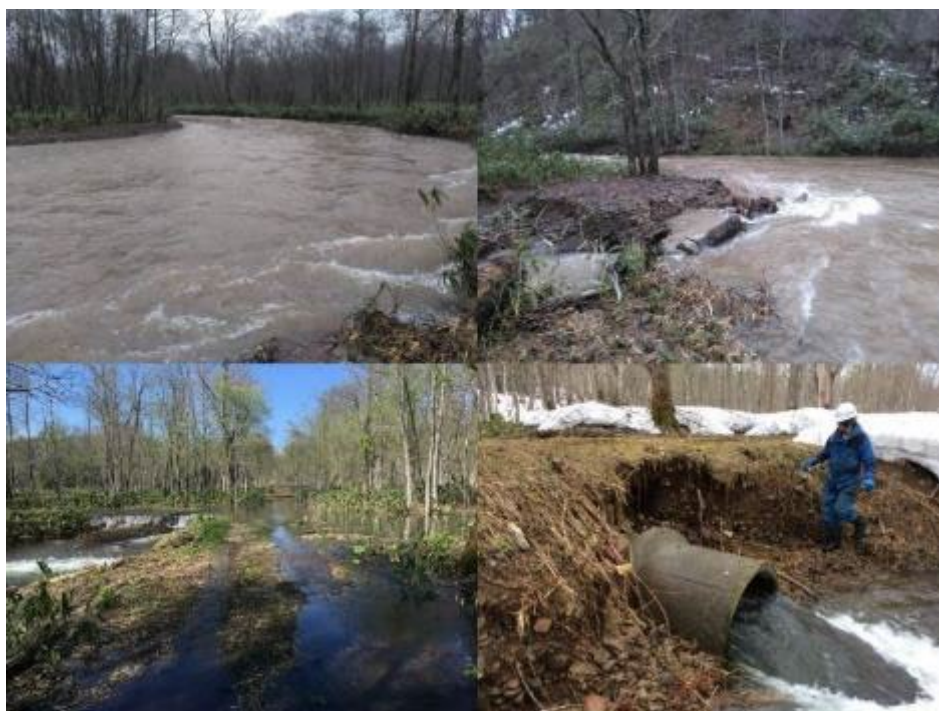
写真2 越流後のブトカマベツ川と林道
