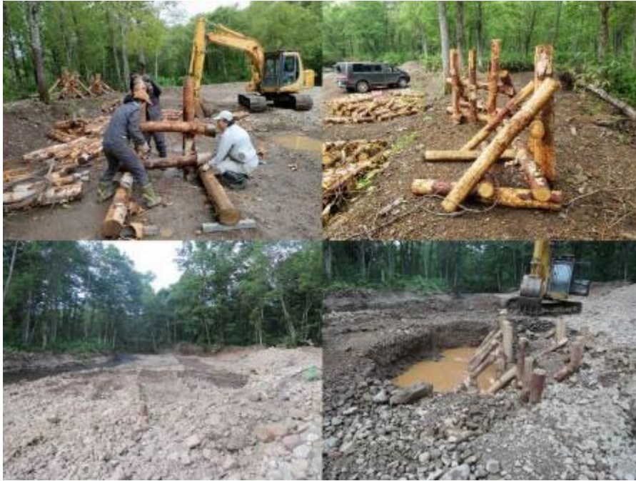
写真4 三角枠バープの作成風景
