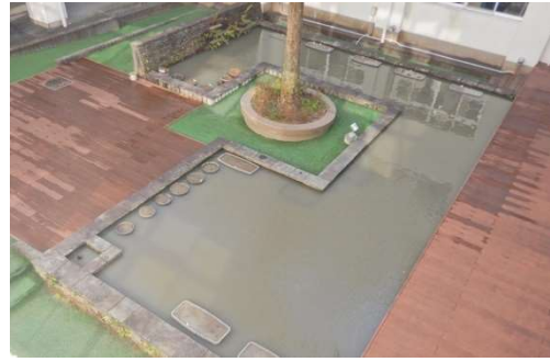
写真 5.8 作業終了し清掃完了
