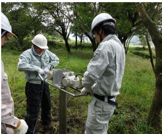
写真 3.1 バイブレーターによる打ち込み
