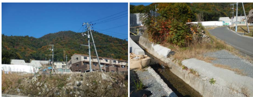
写真2.5 八木地区県営住宅上流の砂防堰堤（左）と下流に伸びる流路（右）
