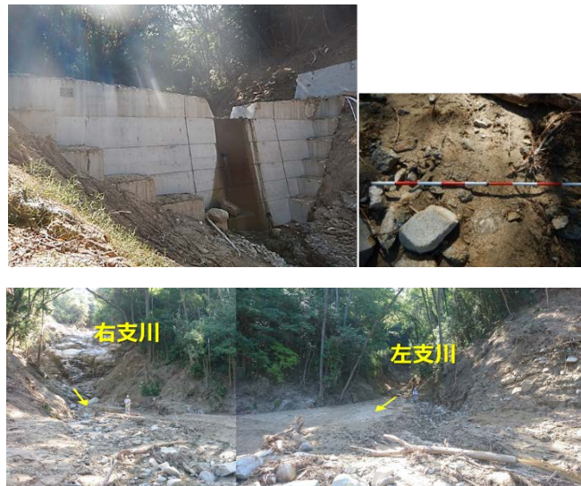
図3.6 矢野東13溪流の治山堰堤（左上）と堰堤上流の堆積（右上）、堰堤上流の状況（下段）
