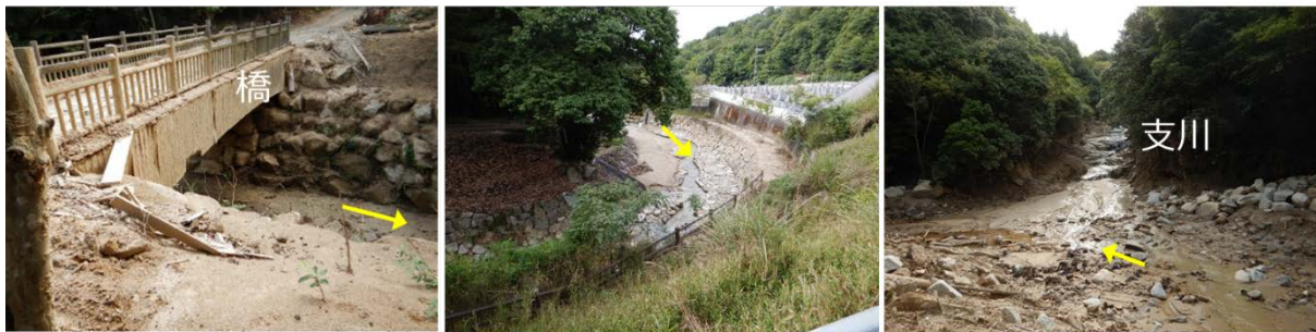
写真 2.6 水分狭の中流部（左：下流で閉塞した橋、中央：堆積が少ない中流のエリア、右：堆積が多い上流のエリア）
