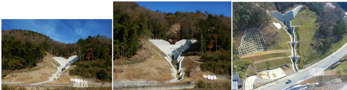
写真2.4 徳尾の砂防堰堤（左：下流から望む、中央：本堤を正面より撮影、右：上空から望む 6) に加筆）
