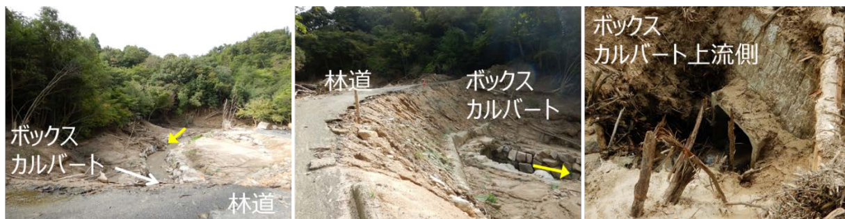
写真 2.7 水分狭の上流部での林道との合流箇所（左：合流部の上流側、中央：合流部の下流側、右：ボックスカルバートを上流より望む）
