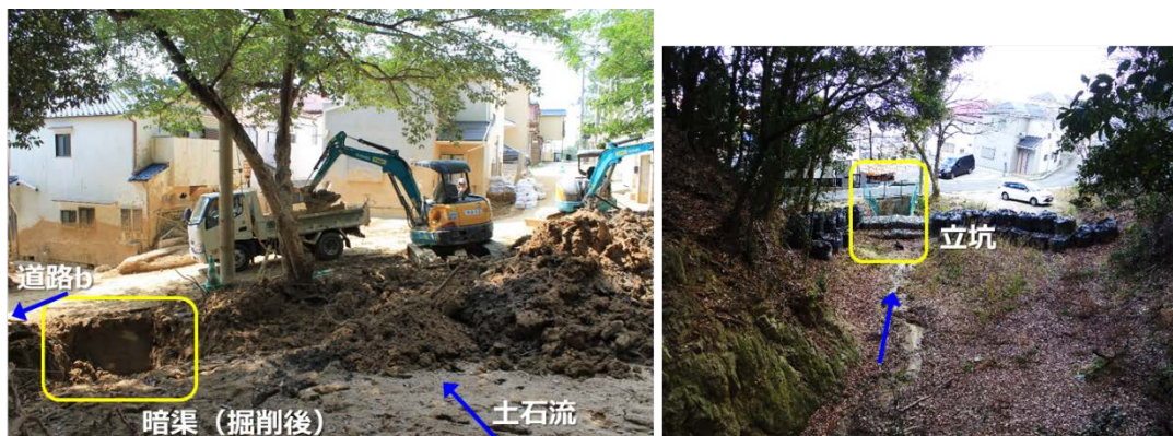
図3.3 篠原台での谷出口付近の暗渠と道路の位置（調査時に撮影、左）、掘削後の立坑を上流から望む（排土復旧後に撮影、右）
