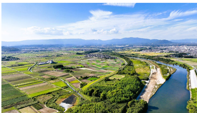
図 3 撮影したドローン映像（津市須ヶ瀬地区）
