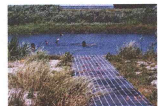
完成後の八潮市側の第1池に水ガキ出現
