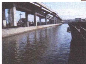
内匠橋から下流は東京都の管理で 殺風景な護岸が続いている
