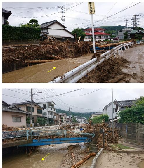
図 2.1 平成 30 年 7 月豪雨により流木で閉塞した総頭川の橋梁（2018 年 7 月 8 日撮影）
