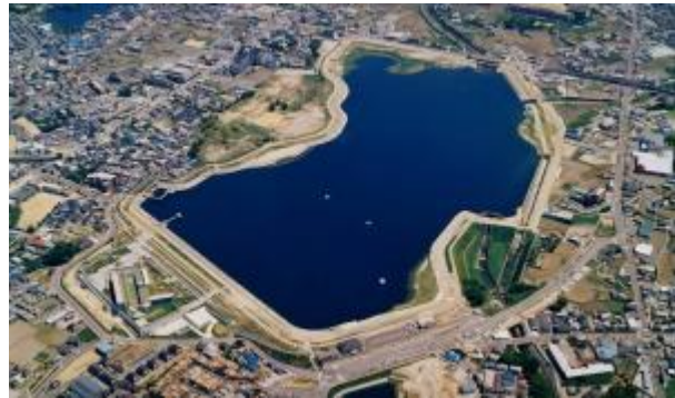
図 現在の狭山池ダム
