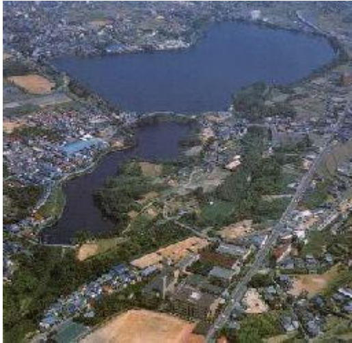
図 工事前の狭山池ダム
