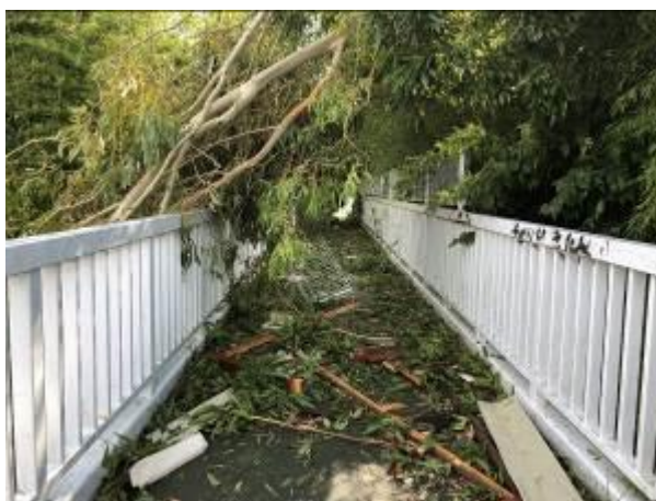
図 2.1-9 西除川に架かる吊橋と狭山池附属池の被害の様子
