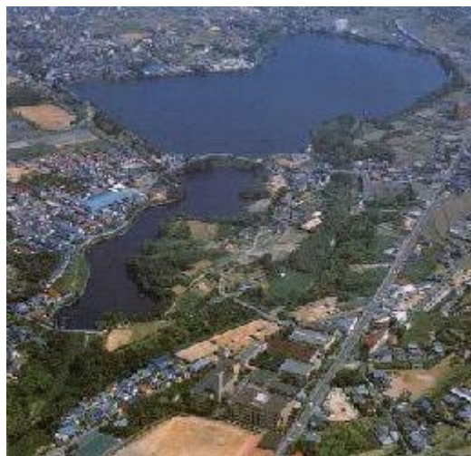
図 工事前の狭山池ダム
