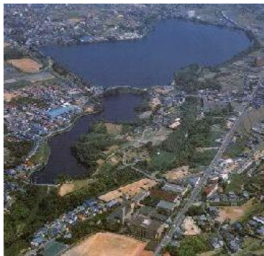
図 工事前の狭山池ダム
