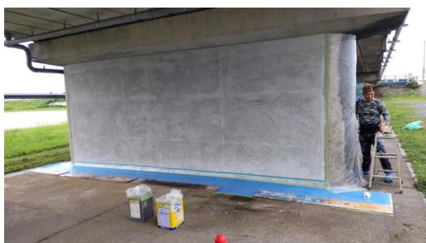
写真-2.10-4 下地処理シーラー処理
