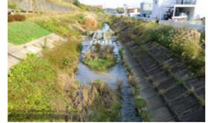
工事後、カゴマットに土砂が溜まり、草が生えてきている
