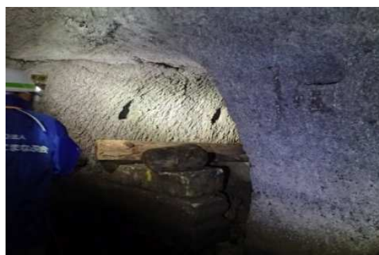
図 2-1-3 トンネルの点検
