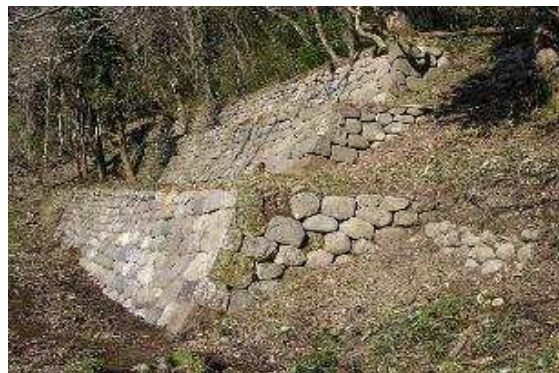
図 1-7 三段石垣(金沢市提供)
