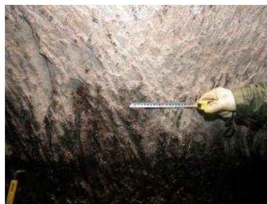
図 1-11 ノミやツルハシの跡（左上から右下へ、右上から左下へと跡が交差していることから接合点であることがわかる。辰巳用水にまなぶ会）
