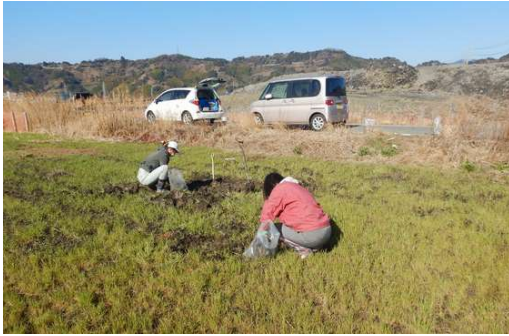
写真 5.1 遊水地工事個所の表土を採取
