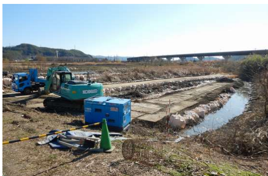
写真 3.1 しゅんせつ工事中（昨年度）
