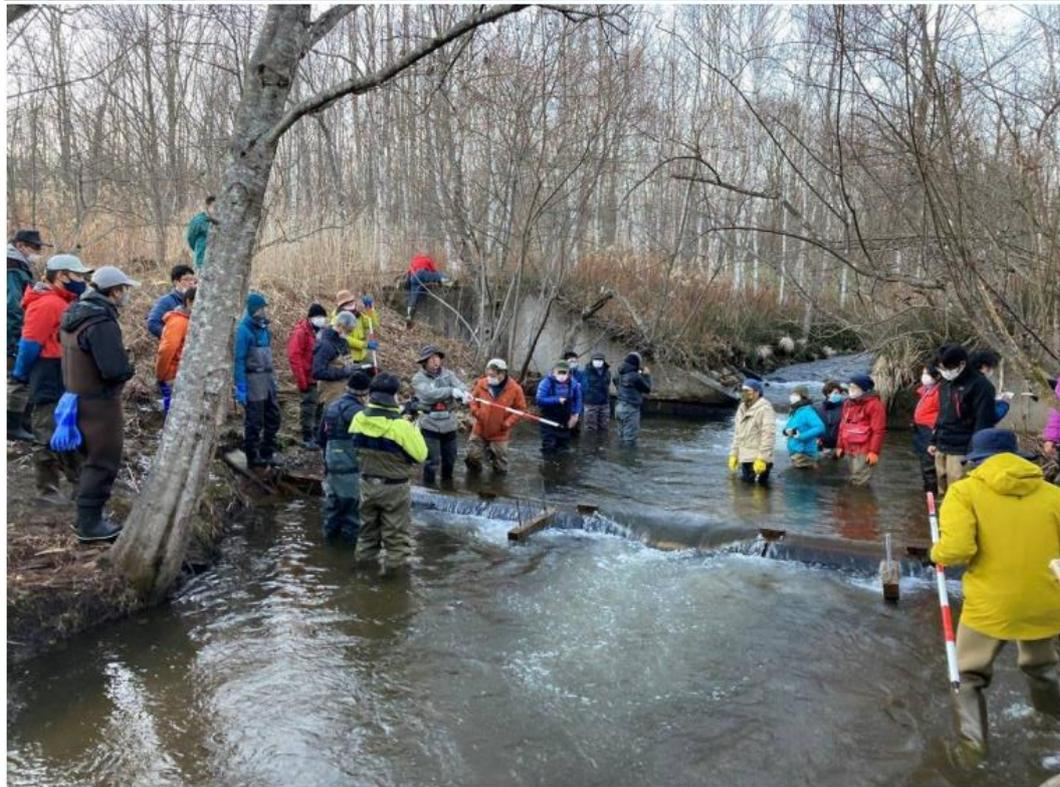
直下型落差での堰板全断面魚道
