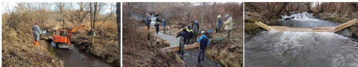
写真7. 魚道制作作業の様子
