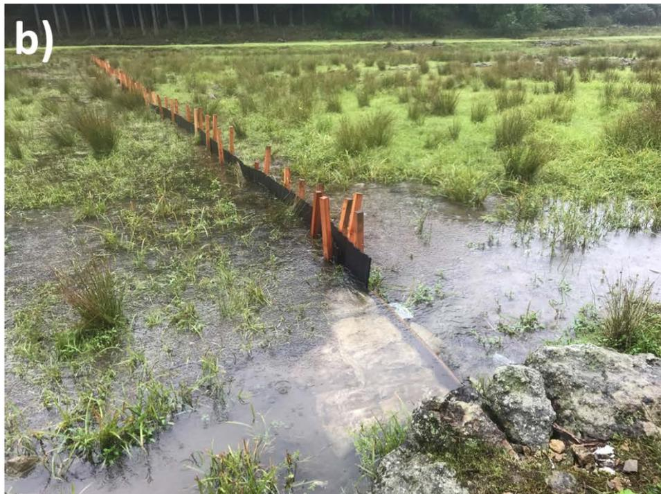
図 4.1 止水板の効果を検証するために二次元流れ解析を実施した対象地域(黒枠)と止水板の位置(赤枠) (a) 及び湿地内に設置されている止水板の例 (b)
