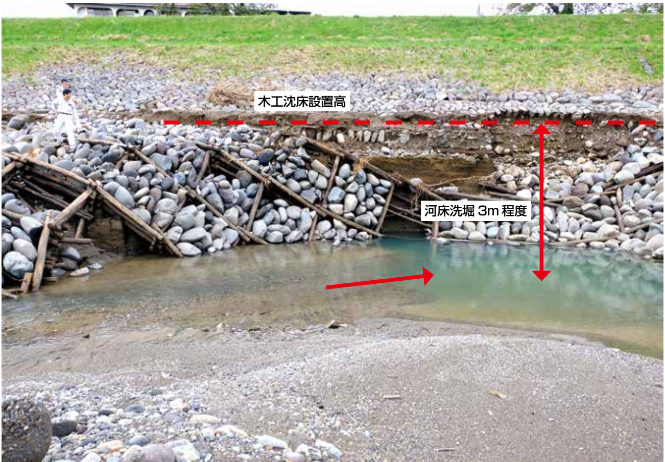
写真6 低水路より左岸側堤防被災箇所近景望む
