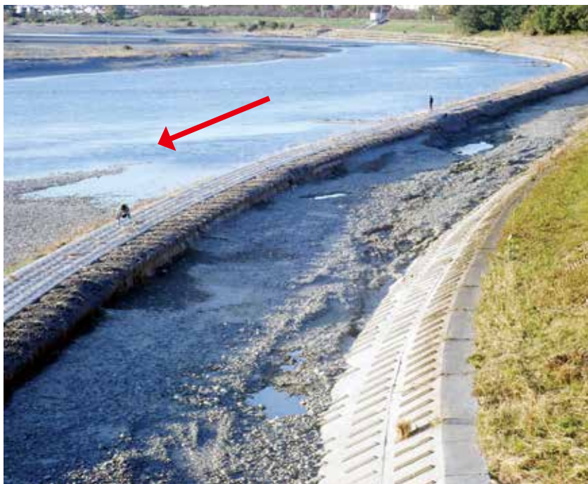
写真4 湾曲区間内湾側高水敷の洗掘(多摩川23.3k付近)
