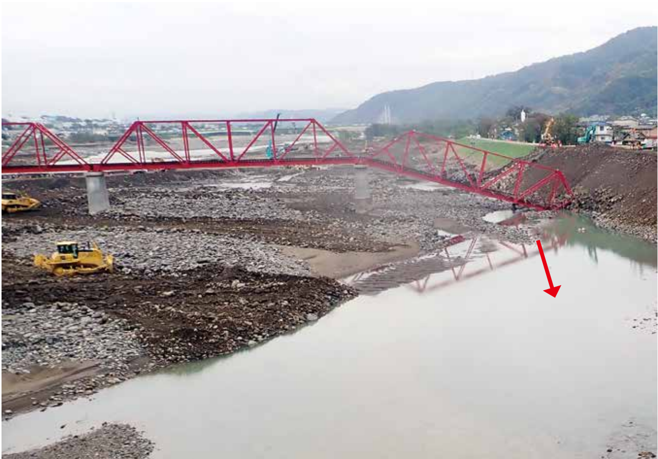
写真5 上田橋より上田電鉄橋梁被災箇所全景望む
