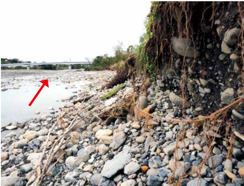
写真2 羽村堰下流河岸侵食（近景）
