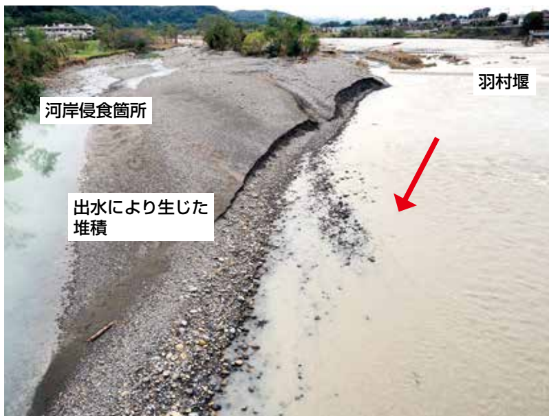
写真1 羽村堰下流河岸侵食（全景）
