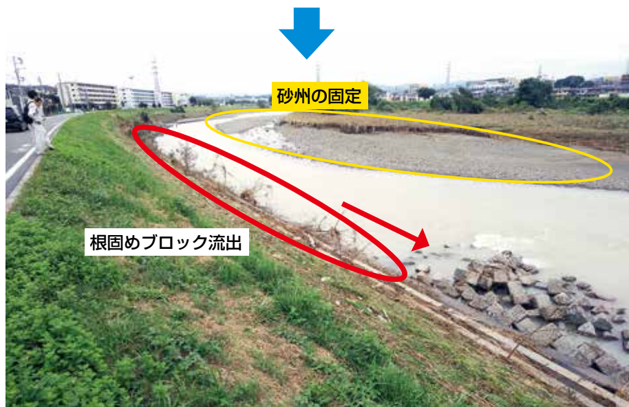
写真3 根固めブロック流出箇所 (浅川4.5k 付近)
