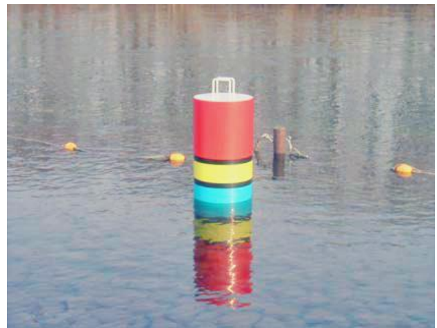
図4・1 水位標識設置事例 (河川水難事故防止対策事例集(平成22年)より)
