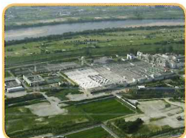
下水処理場全景 【写真提供／淀川左岸流域下水道渚水みらいセンター】
