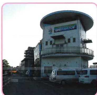
河川防災施設に併設された資料館の一例
