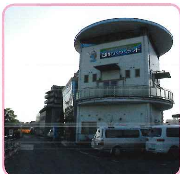
河川防災施設に併設された資料館の一例
