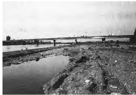
写真 2.3.3 高水敷の表層土の侵食 (多摩川 17.8 km. 2001)
