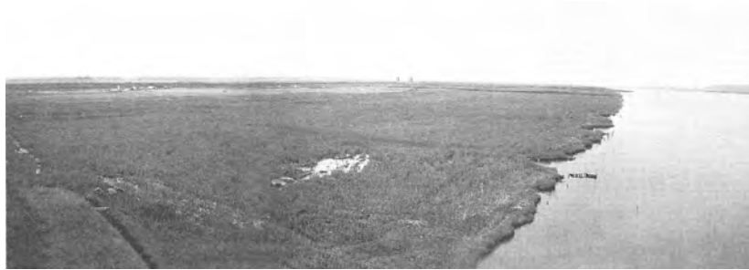
写真 2.4.3 利根川 27.2 km 地点左岸の様子 (1991 年 8 月 11 日)
