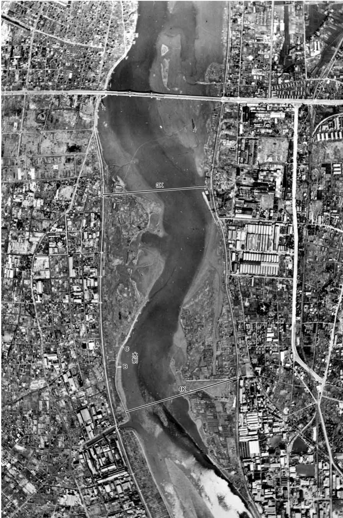
写真1.3 多摩川2.5K~4.5K地点の護岸と水制（1947年）
