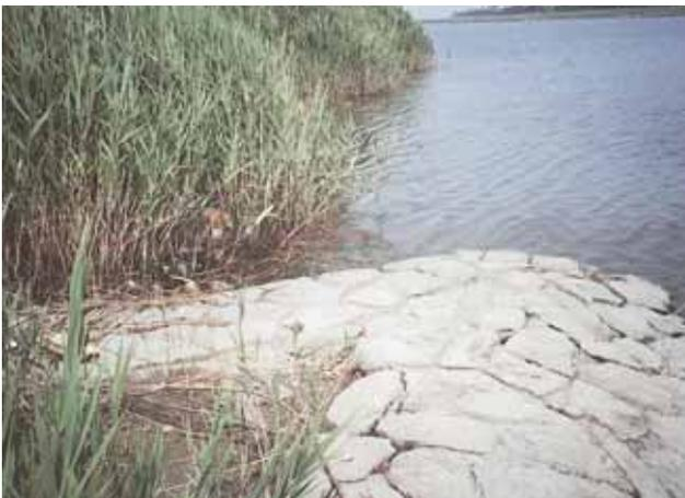
写真3.24 六郷橋下流低水路護岸の最末端部の形状
