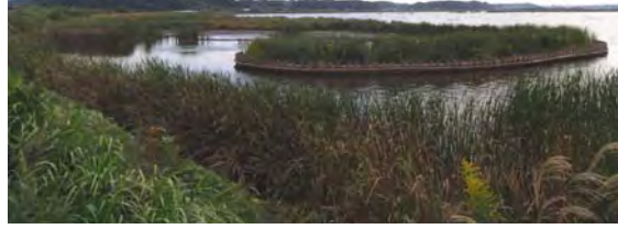
写真 8.15 整備状況 (H20.10.12) 水位 =Y.P.+2.3m 7
