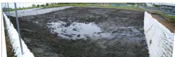
写真 8.7 かつての沼底土を池底表層に敷き均し 7
