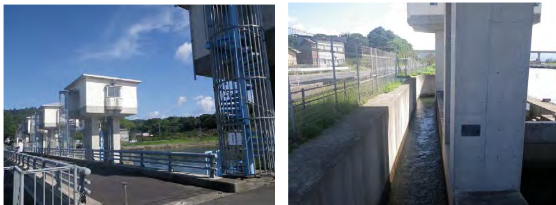
図 7.15 橋津川の潮止堤の全容（左）と右岸側の魚道（右）
