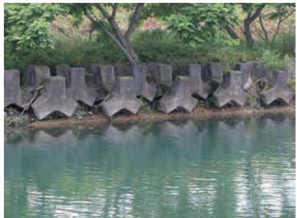
写真2.2.5.8 根固ブロックの露出状況(2009年6月)
