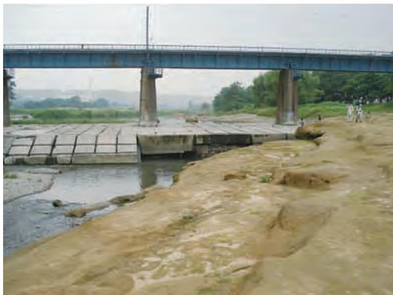
写真1.4.1 橋梁保護根固め工の浮き上がりの事例(多摩川44.7km地点JR八高線橋梁 2009年6月)
