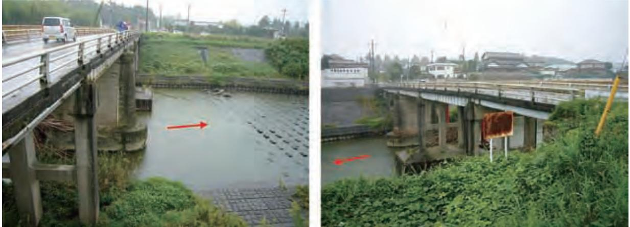
写真2.5.4.8 養老川中流部の橋脚の露出状況(楓橋)(2009年10月)
