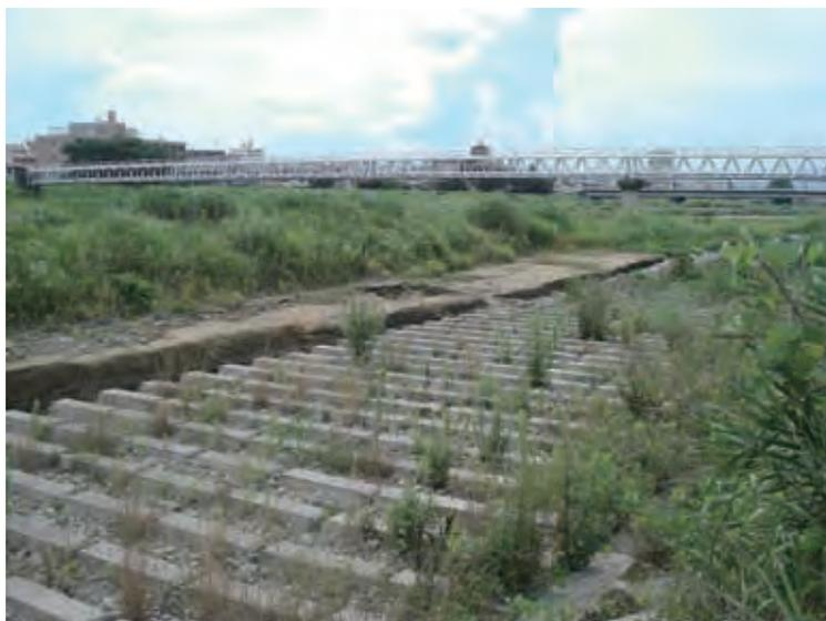
写真1.4.2 護岸根固め工の設置と軟岩の掘削形状(浅川9.6km付近 2010年7月)
