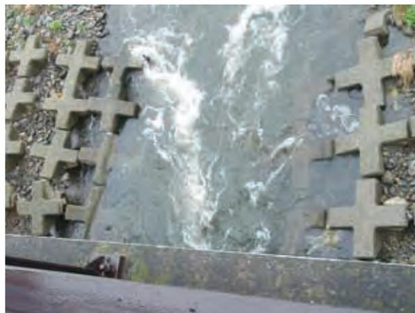
写真2.2.5.20 護床ブロックの低下状況(日野橋40.0km)
