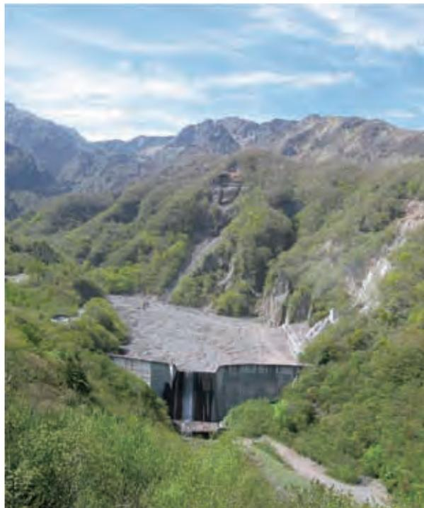
写真2.1.1.1 女峰山と日向砂防堰堤の堆積土砂(2005年5月)
