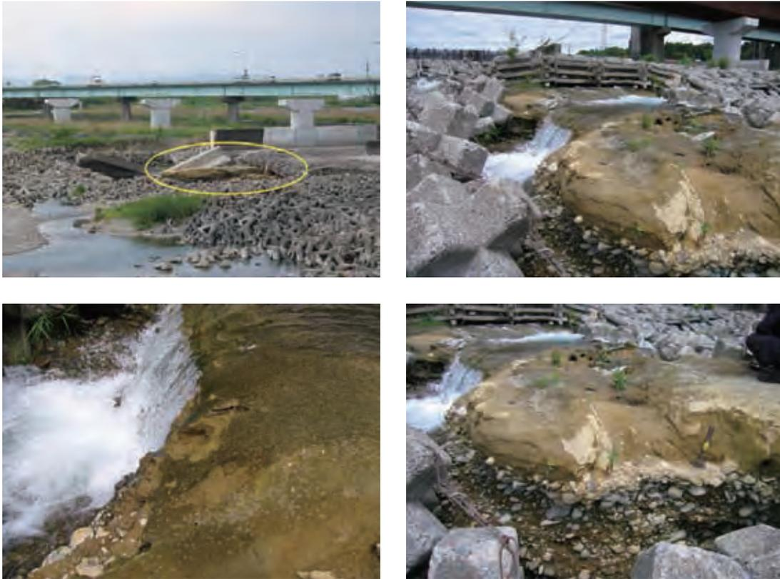
写真2.1.5.3 勝瓜頭首工の直下に分布する洪積粘性土と洪積砂礫層
