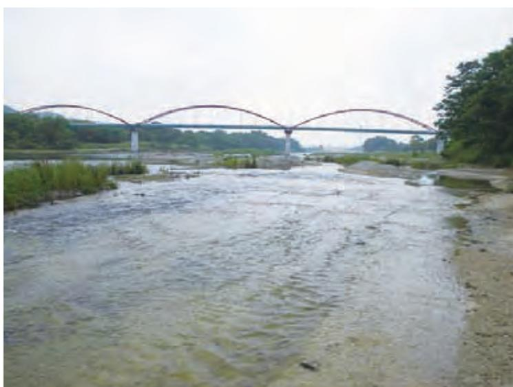
写真1.4.3 河床部に軟岩が露出し河床形状が単調化(多摩川47.1km付近 2009年6月)
