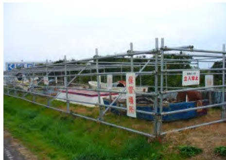
簡易代執行による保管(那賀川)
