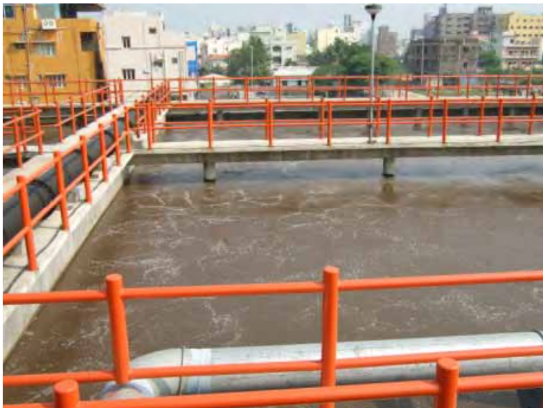
( 写真 - 14 : デュルカムチェルブ処理場の生物反応槽 2 ( 硝化 ) )
