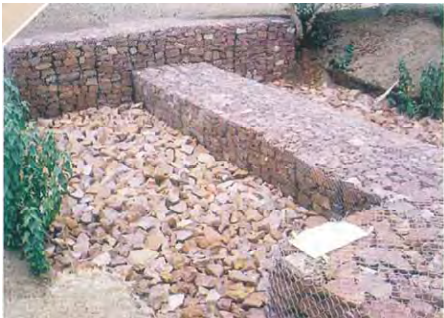
(写真 - 7 : 湖へのシルトの流入を抑制するために設けられたシルト除去槽)
