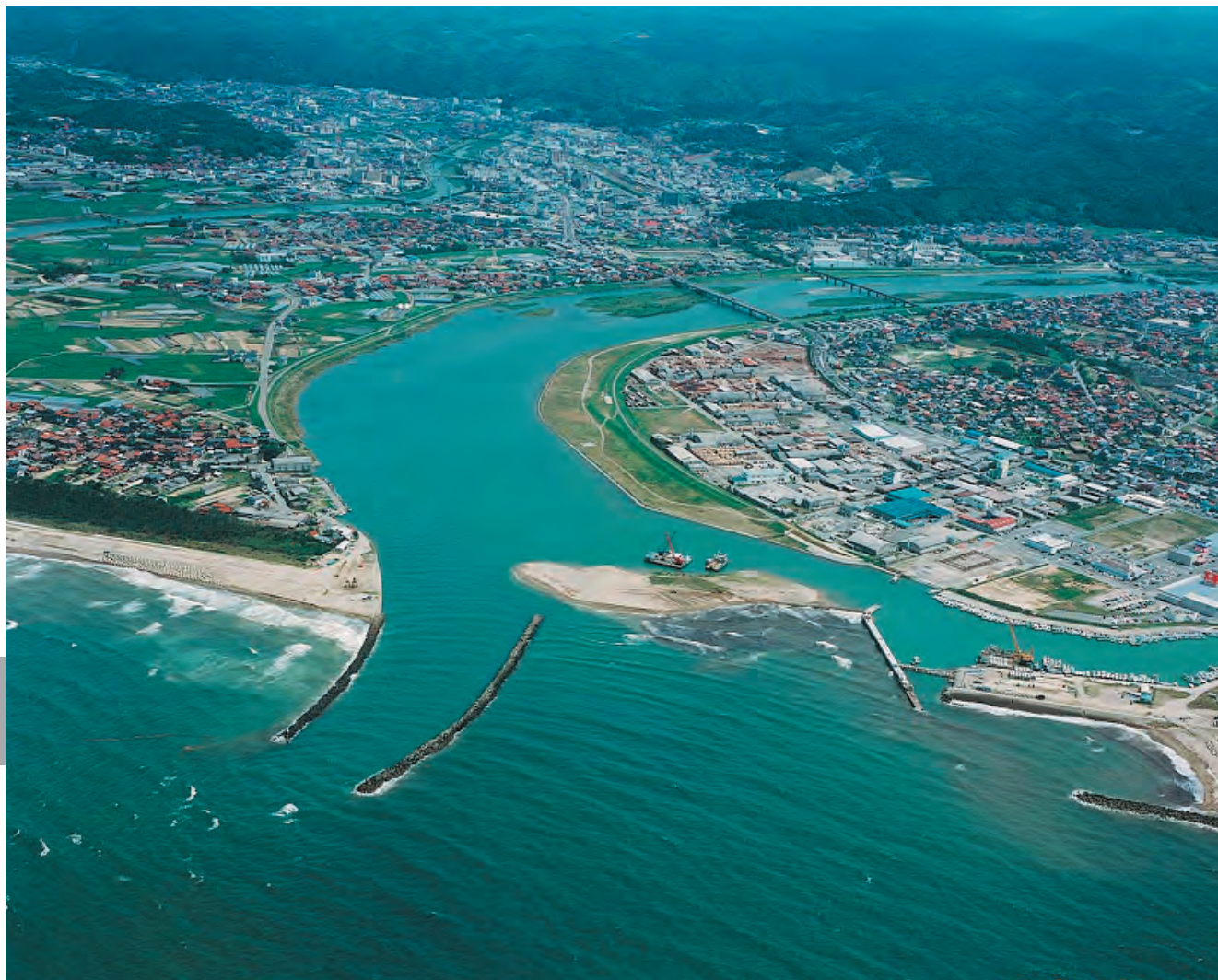
浜田河川国道事務所 撮影 (2003年)
