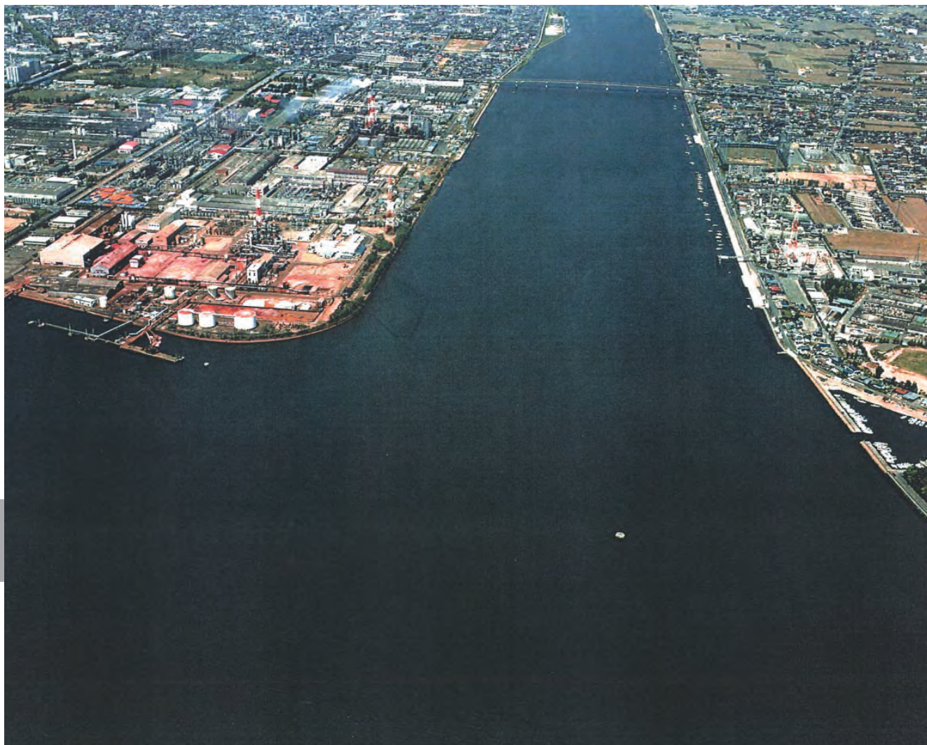
岡山河川事務所 撮影
