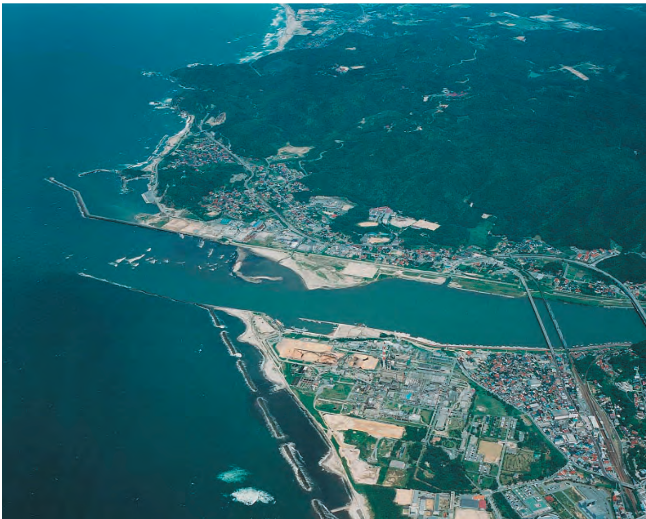
浜田河川国道事務所 撮影 (2003年)
