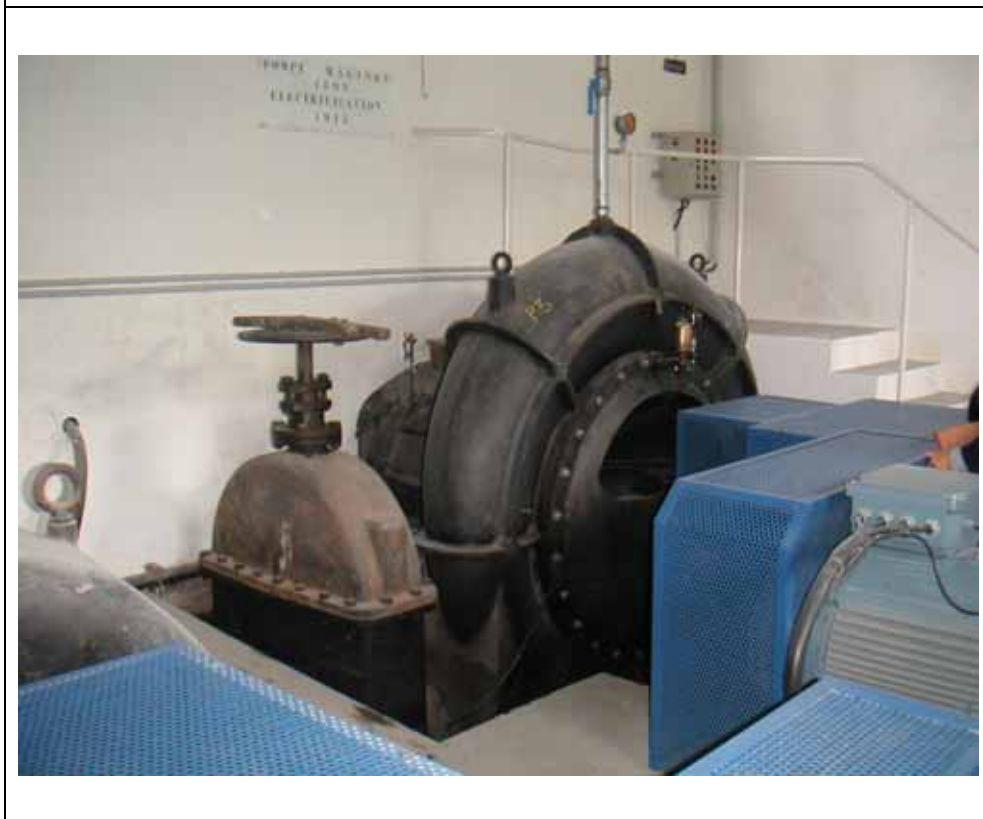
灌漑用の揚水 ポンプ(1893年 蒸気式 1915 年電気式
