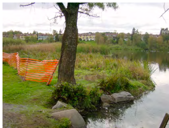
写真-2.19 施工箇所全景
