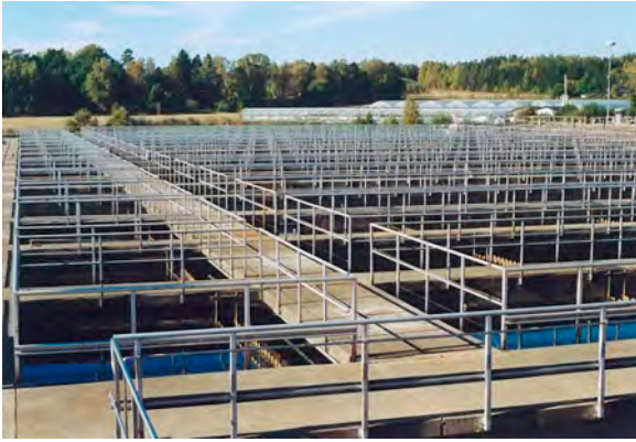
写真-4.2 ストックホルム南西部下水処理社の下水処理施設
