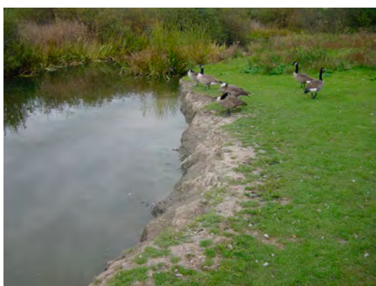
写真-2.16 湖岸侵食箇所
