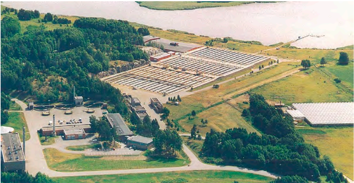
写真-4.4 ストックホルム南西部下水処理社の全景
