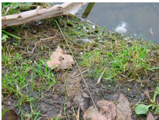
写真-2.18 施工箇所
