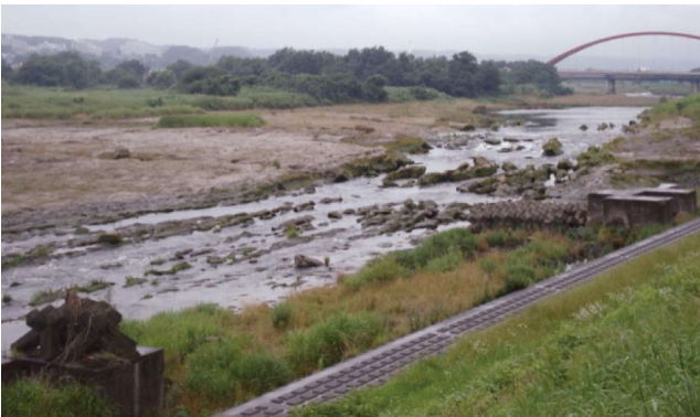
写真 多摩川 43.2km 付近の軟岩の露出状況
