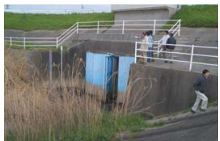
大村樋門(豊川右岸7.3km付近)
