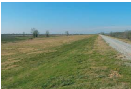
ミシシッピ川下流部の堤防
