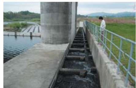
大野頭首工魚道(豊川支川宇連川:鳳来町)
