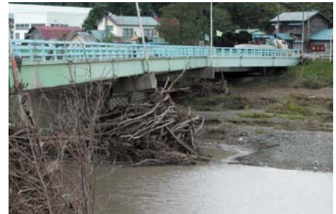
流木による橋梁傾斜被害
