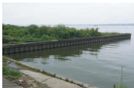
事業実施地区(浚渫土仮置きヤード)外観
