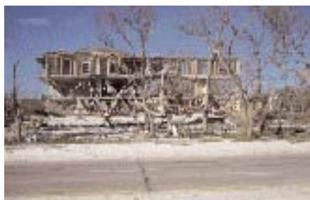
高潮により損壊した家屋（ロングビーチ, 11/30）
