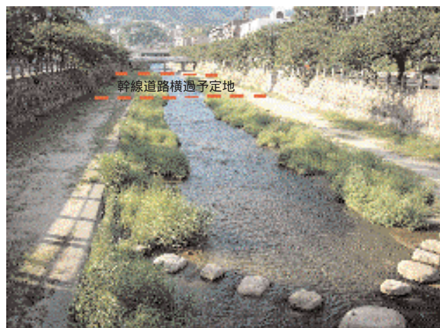
芦屋川工事区間の河川状況
