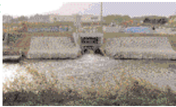
浄化用水の綾瀬川への放流状況
