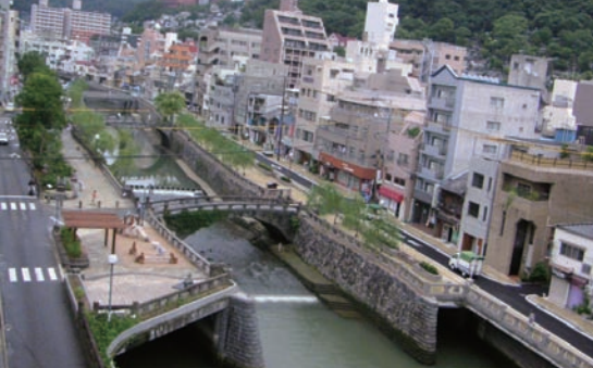
●水害の翌年に再建された眼鏡橋（左）。眼鏡橋周辺は洪水対策として河道の拡幅も検討されたが、兩岸に暗渠式のバイパス水路をつくり、川幅や橋はそのままにした（上）。[上の写真と資料提供/長崎県]
