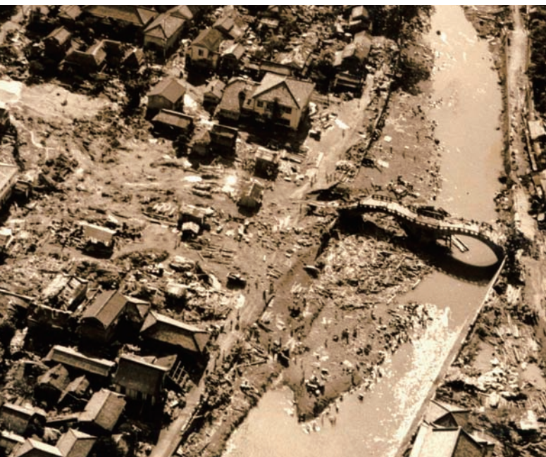
●諫早水害では本明川に架かる石橋の眼鏡橋の両岸で、橋が流れをせき止める形になり、濁流が民家を押し流した。[写真提供/諫早市]
