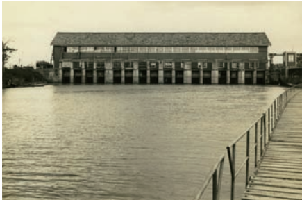
●放水路、排水機場の整備と土地改良事業により、湿地を乾田に変え、多くの努力により、亀田郷(上)をふくむ越後平野は有数の穀倉地帯になった。写真下は1948年完成、当時東洋一といわれた栗ノ木排水機場。[写真提供／亀田郷土地改良区]
