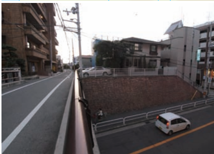
●豊臣秀吉は淀川左岸の現在の枚方市から大阪市長柄間に文禄堤を築いた。文禄堤築堤後、17世紀に大和川は付け替えられ、図のように現在の流路になった（上）。下の写真は文禄堤の遺構。陸橋と道路は堤の上に整備された往時の京街道、石積みは堤の断面にあたる。[資料提供/国土交通省淀川河川事務所]
