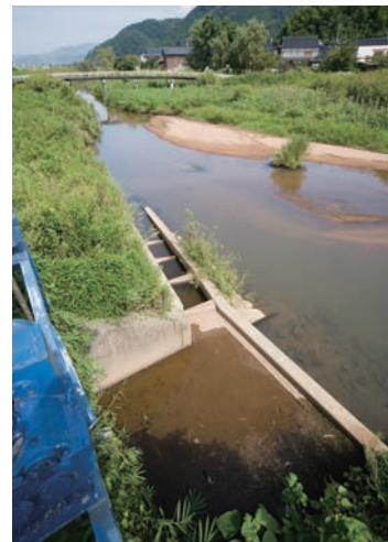
●六方川では兵庫県が樋門のわきに、階段式の魚道を設置したり(写真上・右)、前面にふとんカゴを設置する(写真下)ことで落差を解消した。その結果、六方川から六方田んぼにのぼってくる魚の種類、個体数ともに増加した。
